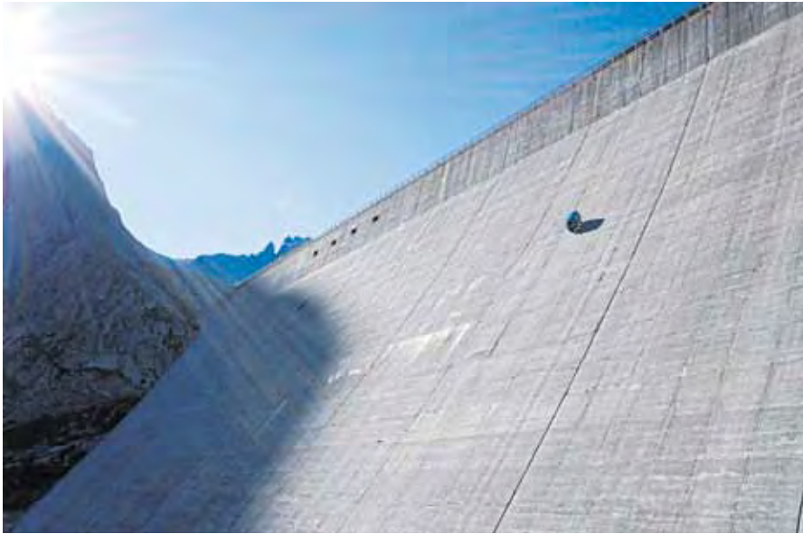
Roman Signer, „Piaggio an der Mauer“, 2017
