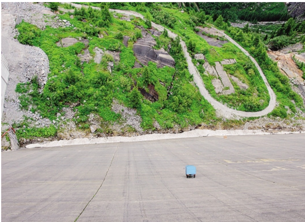
L'Ape Piaggio posizionata sulla parete (in verticale) della diga di Albigna
